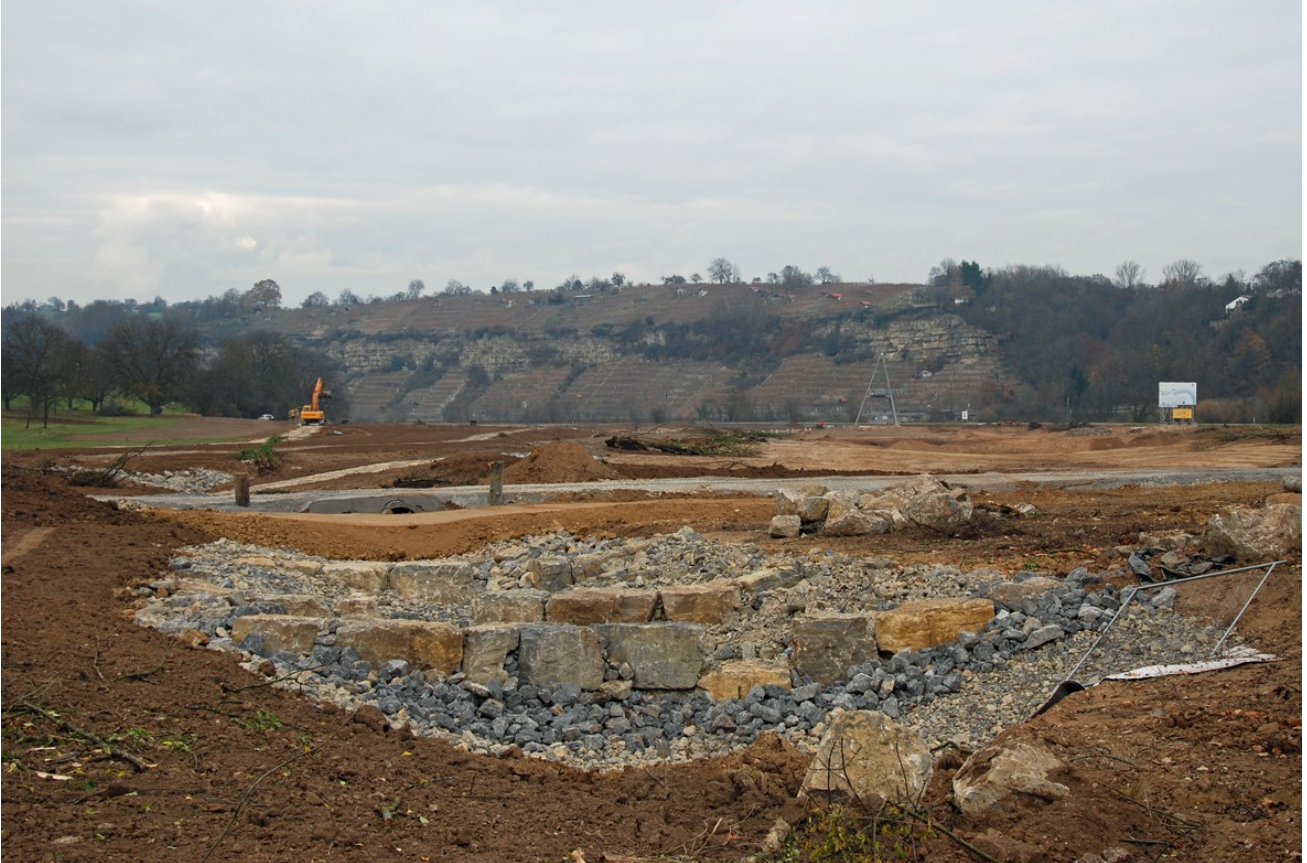
Ludwigsburg: Baustelle während der Renaturierungsmaßnahmen im Projektgebiet Zugwiesen Quelle: © Sabine Schellberg
